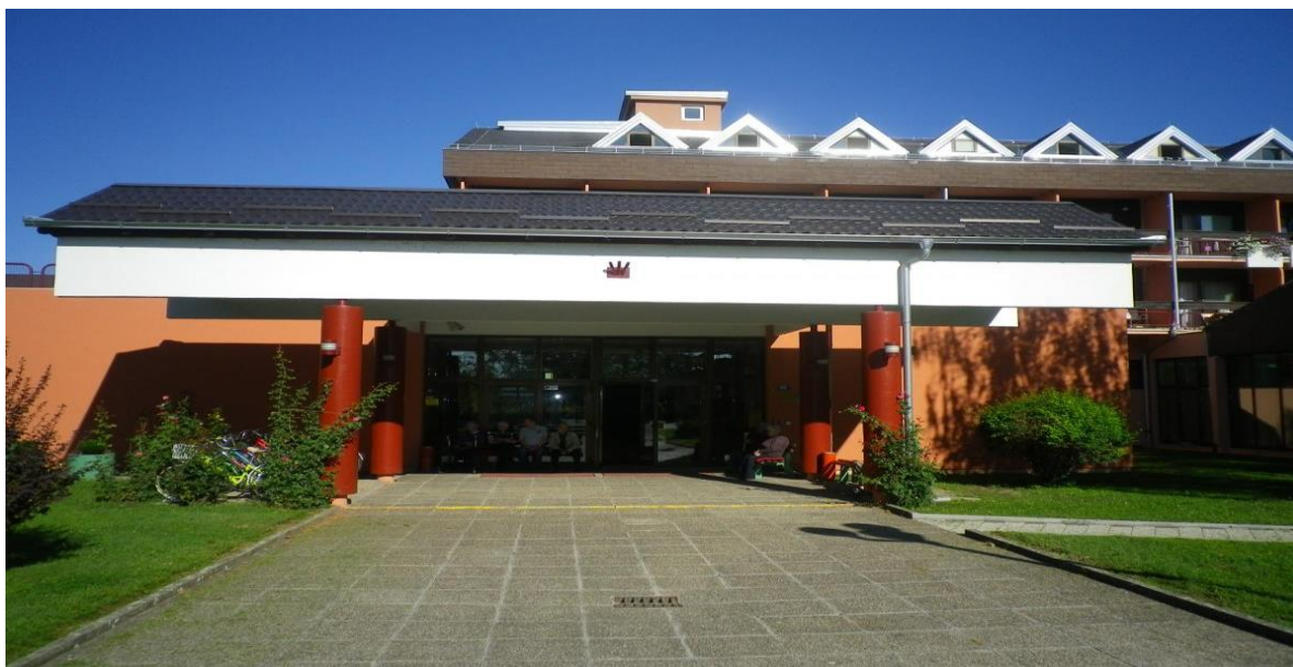
Slika 13 Zgrada Doma za starije i nemoćne Vinkovci
